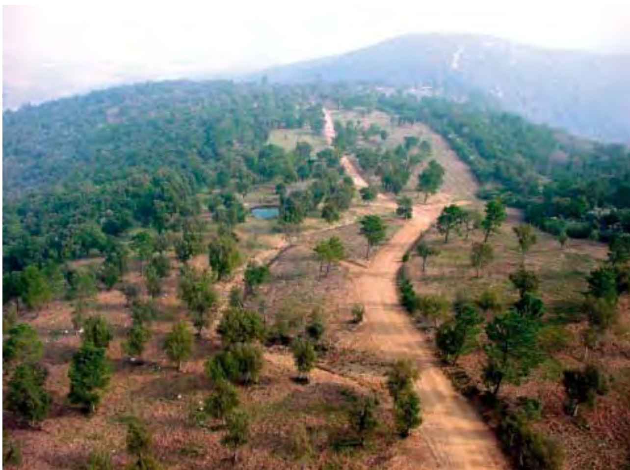
Figure 7 : Exemple de coupure de combustible destinée à limiter les surfaces parcourues par les grands incendies ... Des arbres en bord de piste devraient encore être supprimés pour respecter le gabarit de sécurité. De même, la distance sans arbre en lisière de l'ouvrage n'est pas toujours respectée. (Photo P. Brasseur - SDIS 83).
